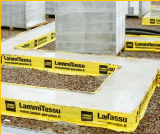
Kun betoni on kovettunut, muottia ei tarvitse purkaa. Näin tontille ei kerääny rakennusjätettä.
