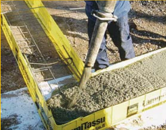
Mahdollisten lisäraudoituksen asennuksen jälkeen valmismuotti valetaan betonilla ja yläpinta tasataan oikeaan korkoon.
