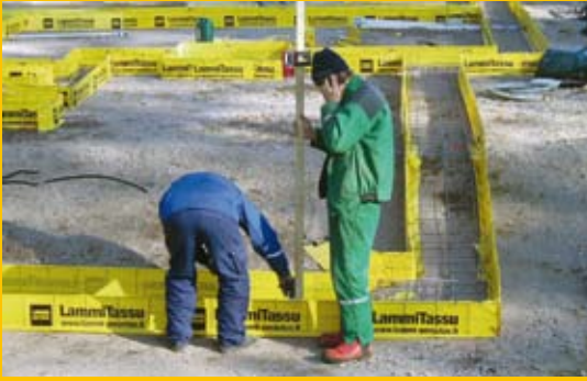
Valmismuotit asennetaan tasatulle ja tiivistetylle maapohjalle.
